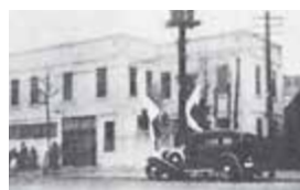
芝区西応寺町の萱場製作所本館
