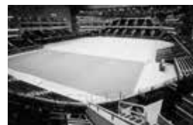
さいたまスーパーアリーナに設置された人工芝自動敷設・巻取大型システム
