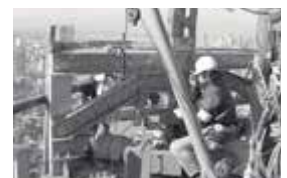
東京タワーへ多機能ダンバを設置
