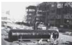
建設中の相模工場
