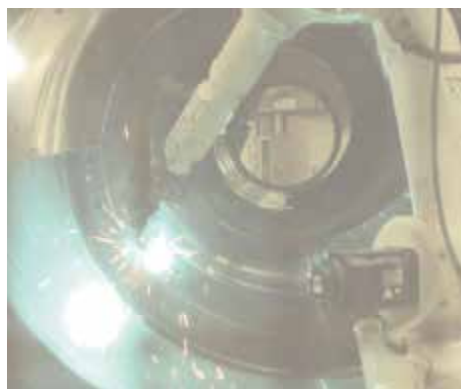
ロボットによる溶接作業
