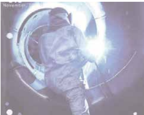
手作業による溶接作業
