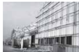
建設中の岐阜工場
