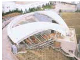
志摩スペイン村 野外劇場シェルドーム竣工
