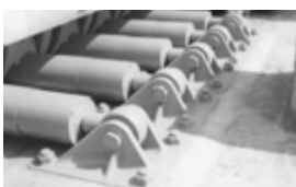
耐震用の橋梁ダンパ
