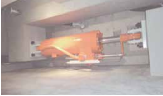
変位検知切換型オイルダンパ
