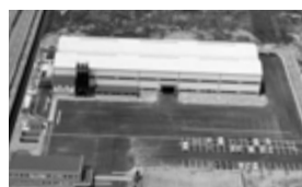
三重装置工場
