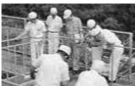
金山に設置された 廃水処理施設の環境診断
