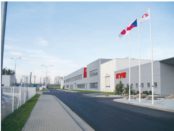
写真1 KMCZの工場外景（手前は既存建物、奥が拡張部分）
