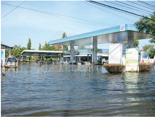
写真11 洪水で水没したガソリンスタンド
