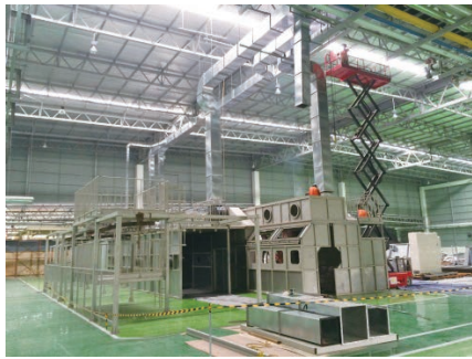
写真3 現地工事業者による塗装装置再組立の様子
