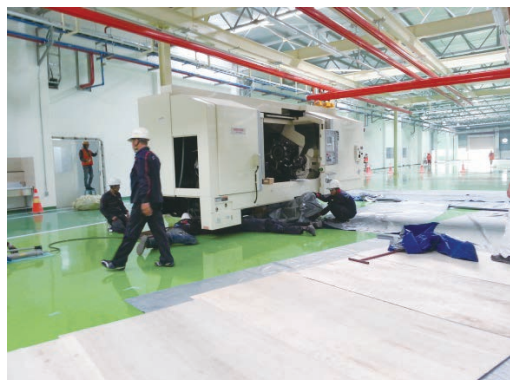
写真6 設備搬入の様子
