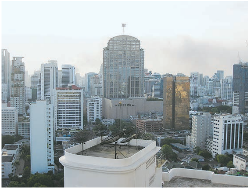
写真8 中央のビルの左の奥から立ち昇る煙
