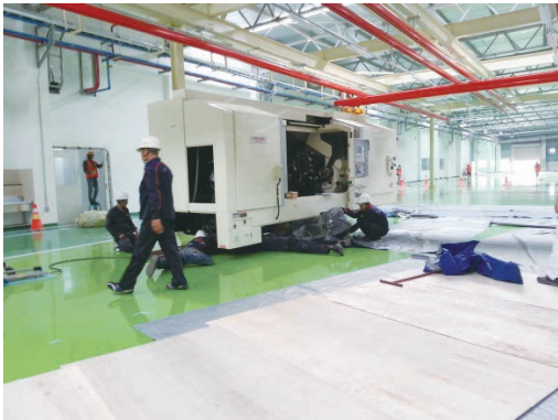
写真6 設備搬入の様子
