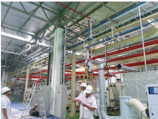
写真7 現地従業員によるホース接続の様子
