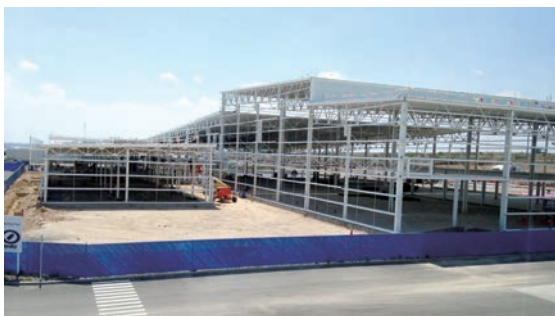
写真7 建設中のSA工場
