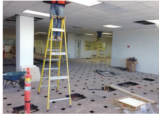
写真3 工事中のKMEX事務所
