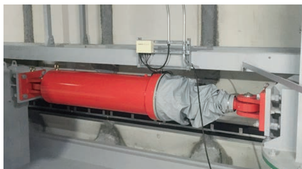
写真2 ロック機構付きオイルダンパ取り付け例
