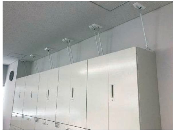
写真6 KYB熊谷工場モニタ設置状態
