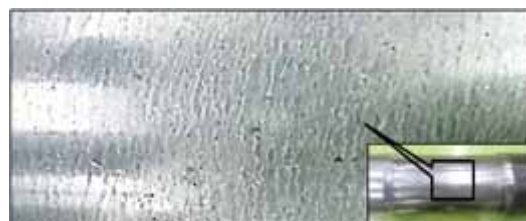
写真3 うろこ状の外面剥離
