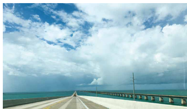
写真7 セブンマイルブリッジ
