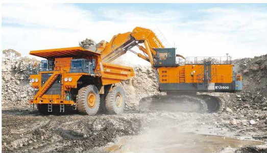
写真1 マイニングダンプ積み込み風景 （日立建機様ホームページより転載）
