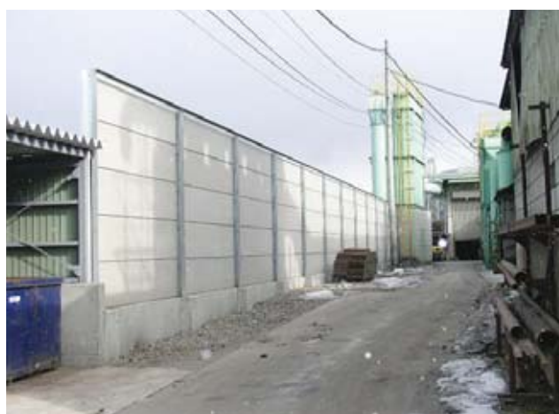
敷地境界の防音壁〔KYBキャダック(関係会社)〕
