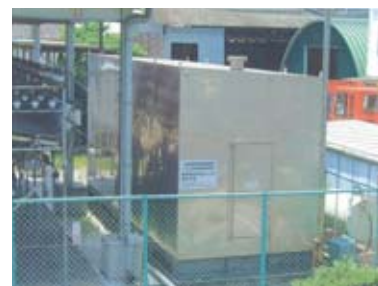
PCB保管庫(岐阜南工場)
