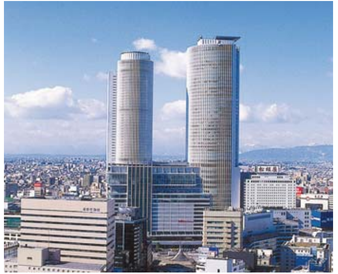
当社製制震システム採用のビル
