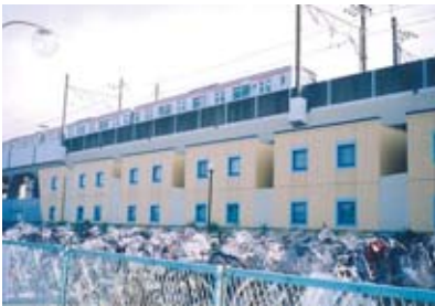
吊り免振工法のホテル
