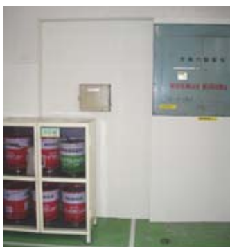
アスベスト囲い込み状況(岐阜北工場)
