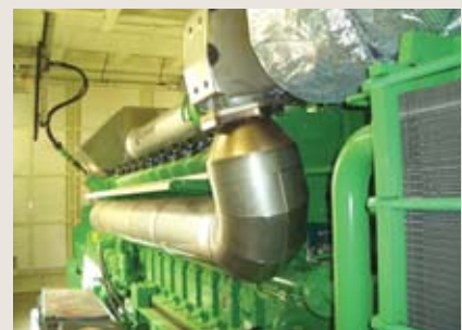
運転を開始したコージェネ設備(相模工場)
