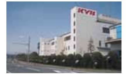
花と緑に囲まれた工場外観（岐阜北工場）
