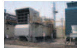
ボイラー燃料転換によるCO 2 低減
