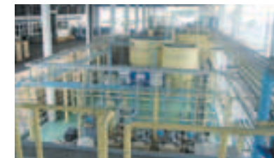
排水浄化処理設備
