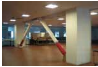
制震用オイルダンパの設置例(岐阜北工場)
