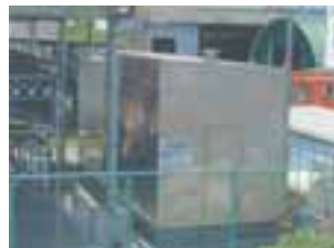
PCB保管庫（岐阜南工場）
