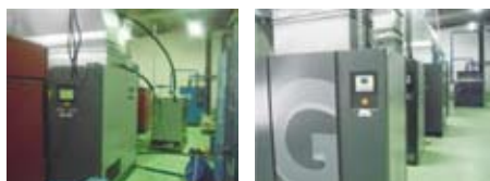
以前のコンプレッサー室
