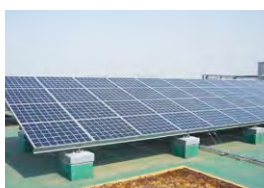
新たに採用した太陽光パネル
