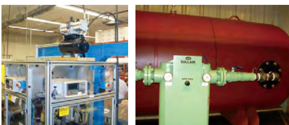
工場全体のエア使用環境を調査
