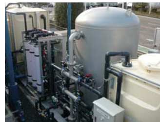
浄化システム
