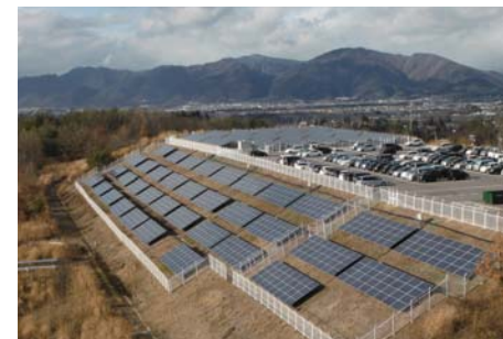
太陽光パネル設置状況
