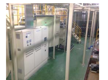
廃水処理装置の一部
