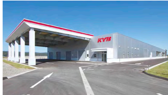
Eco-Friendly Plant (KYB Trondule Co., Ltd.)
