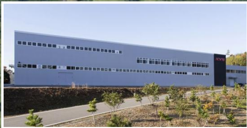
システム実験棟 (2015年3月 稼働)
