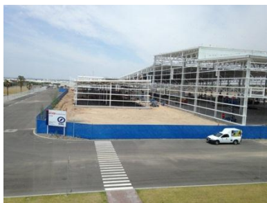
建設中のSA工場の様子 (2015年5月時点)
