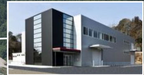
電子実験棟 (2014年4月 稼働)
