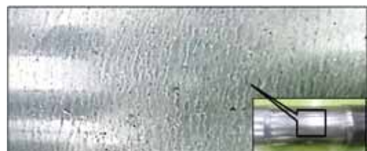
写真3 うろこ状の外面剥離
