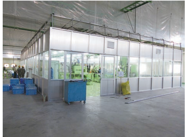
写真5 組立ラインの設置
