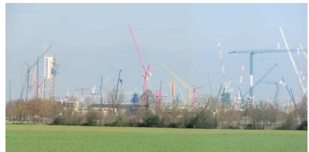
写真1 列車から見たBauma会場
