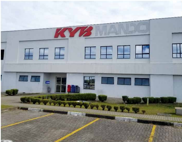
写真1 MANDOの跡がくっきり残った正面建屋
