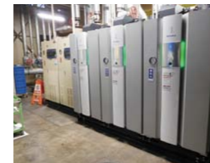
小型貫流ボイラー全体
