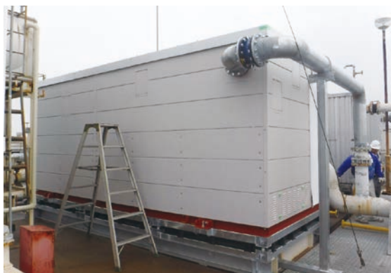
岐阜北工場A棟 空調用ガス焚き吸収式冷温水機
