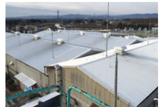
遮熱塗装施工後の屋根
