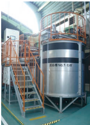
設置した処理装置
