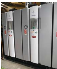
小型貫流ボイラー全体
