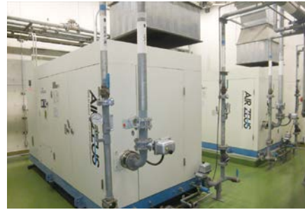
遮熱塗装 施工前
