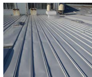
遮熱塗装 施工後
