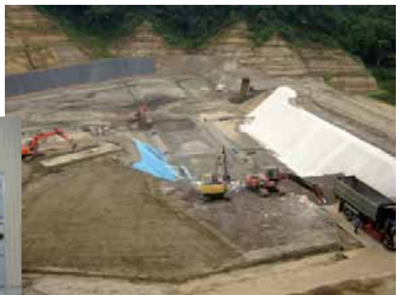
廃棄物処分場の現地確認
