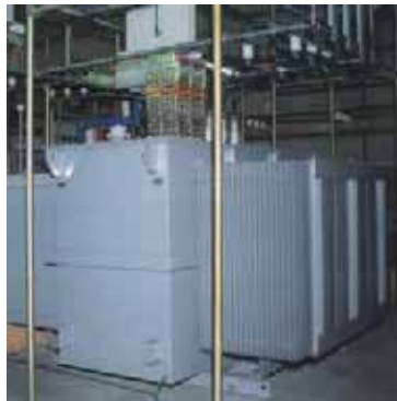
国内最大となる4,000kVAアモルファストランス (岐阜北工場)
