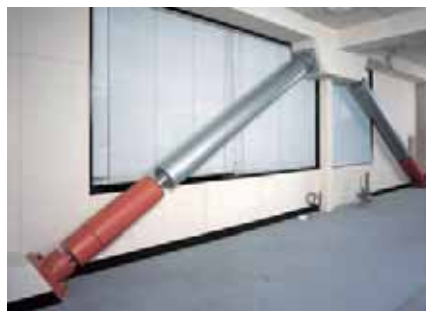
当社制震用ダンパによる建物の補強（岐阜南工場）
