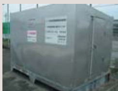
PCB保管庫（岐阜北工場）
