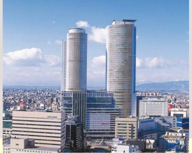
当社製制震システム採用のビル
