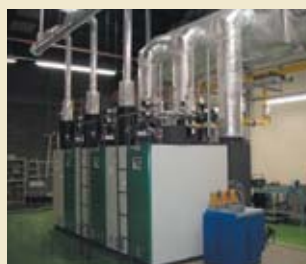
都市ガス仕様のボイラーと都市ガス受入配管(岐阜北工場)
