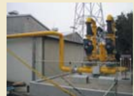
都市ガス仕様のボイラーと都市ガス受入配管(岐阜北工場)
