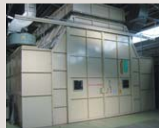
新設された塗装ブース（熊谷工場）
