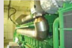
ESCO事業により導入された 2500Kwガスエンジン
