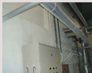
ボイラー室のアスベスト撤去状況（KYB金山）
