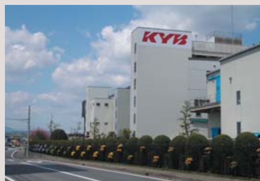
花と緑に囲まれた工場外観 (岐阜北工場)
