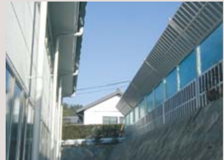
敷地境界の防音壁 [柳沢精機製作所 (関係会社)]
