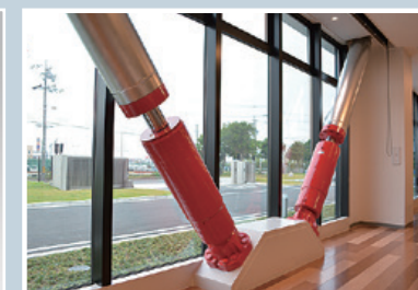
制振ブレースオイルダンパ
