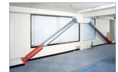
制震用オイルダンパ Vibration Control Dampers
