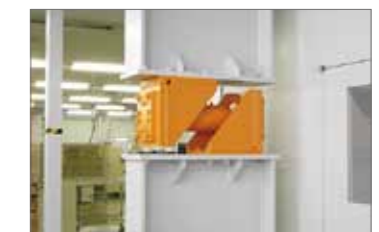
間柱型オイルダンパ Stud Type Oil Damper
