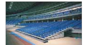
エアアベアリング式観客席移動システム [北九州メディアドーム] Movable and Retractable Seating Units with Air Bearing : KITAKYUSHU MEDIA DOME
