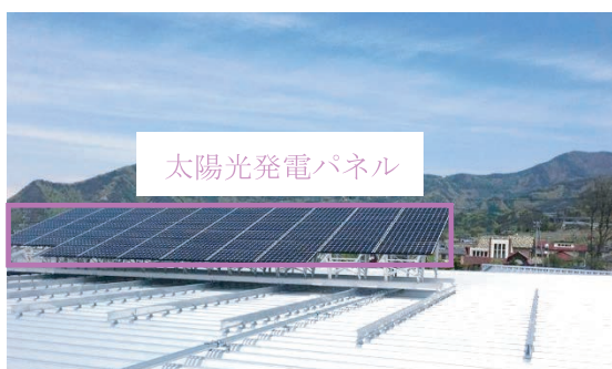
写真5 建屋屋上太陽光パネル
