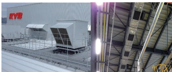
写真7 工場外・屋内給気装置
