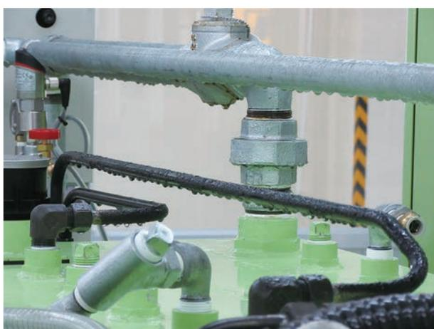
写真12 油圧配管の結露
