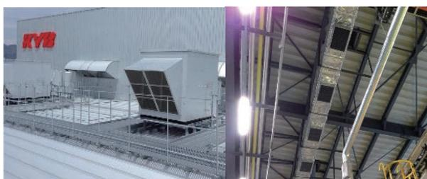
写真7 工場外・屋内給気装置
