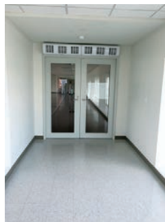
写真5 エアシャワー
