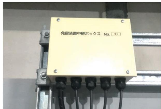
写真8 中継ボックス 外観
