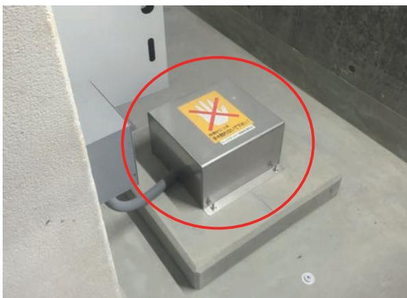
写真5 加速度計 外観
