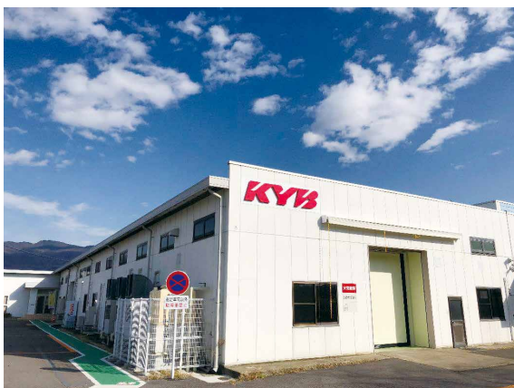
写真1 工場建屋外観
